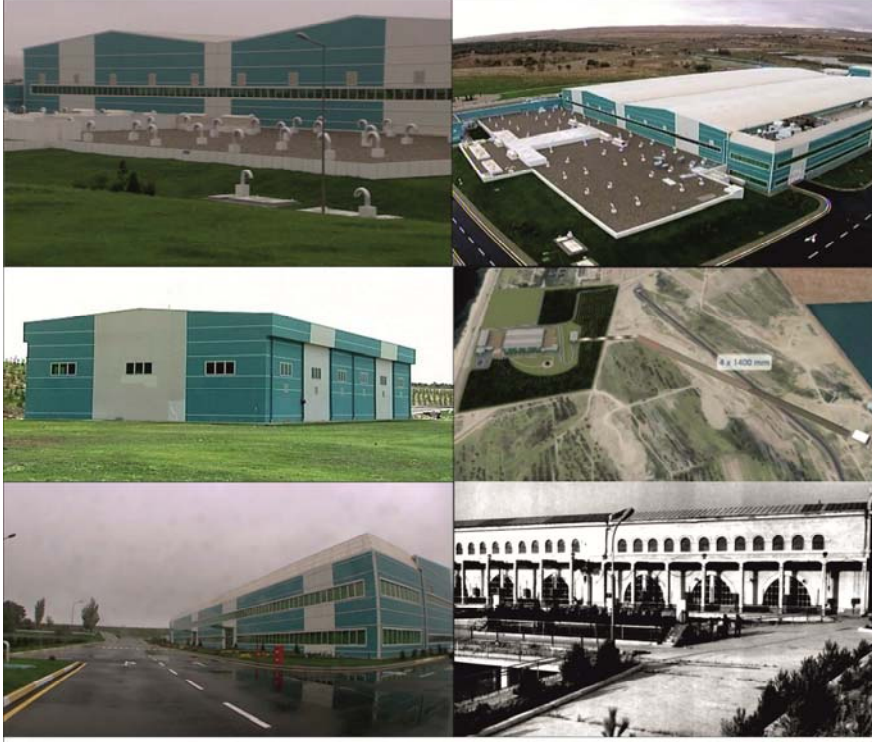
CEYRANBATAN SU ANBARINDA NASOS STANSİYASININ BİNASININ MEMARLIQ-PLANLAŞDIRMA HƏLLİNİN TƏMİR-BƏRPA İŞLƏRİNDƏN ƏVVƏL VƏ SONRAKI GÖRÜNÜŞLƏRİ
