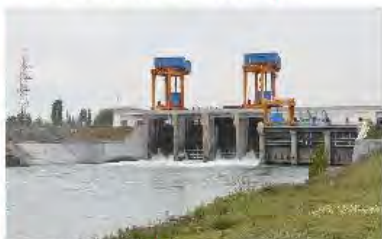
"Varvara" Su Elektrik Stansiyası.
