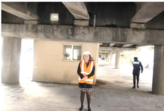
Рис. 7. Фото оборудования на эксплуатируемом мосту
