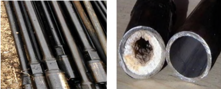
Şəkil 18. Boruların səthinin tətbiqdən əvvəl və sonrakı təsviri
